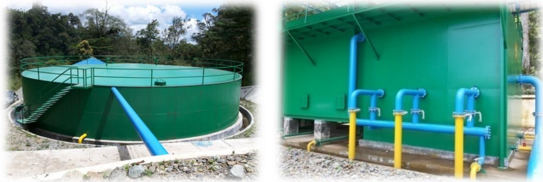
Gambar 35. Bak Penampungan dan Penjernihan Air PDAM Tirta Sakti di Taman Nasional Kerinci Seblat yang Baru Dibangun tahun 2016
